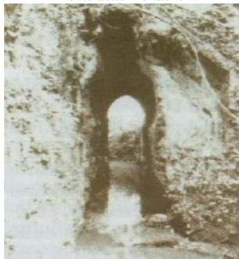
Ponte delle Monache
