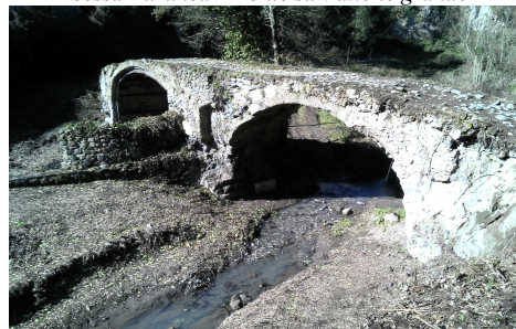
Sessa Aurunca – Ponte su Vallone grande
